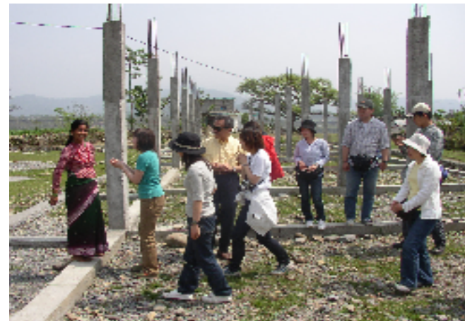
現在は土台のみできています。
